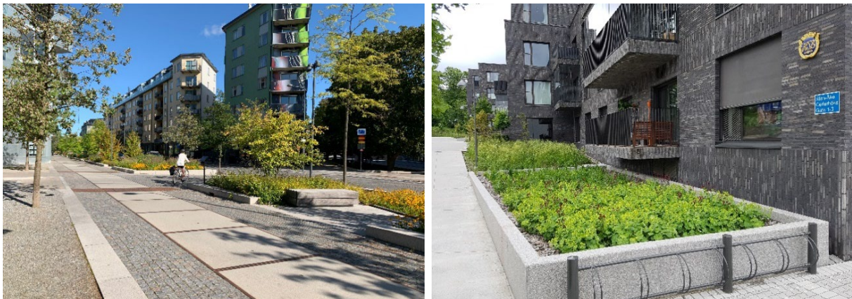
Figur 3. Exempel på lokala dagvattenlösningar med växtbäddar på allmän platsmark och på kvartersmark i Norra Djurgårdsstaden och i Göteborg (Foto: Bjerking).
