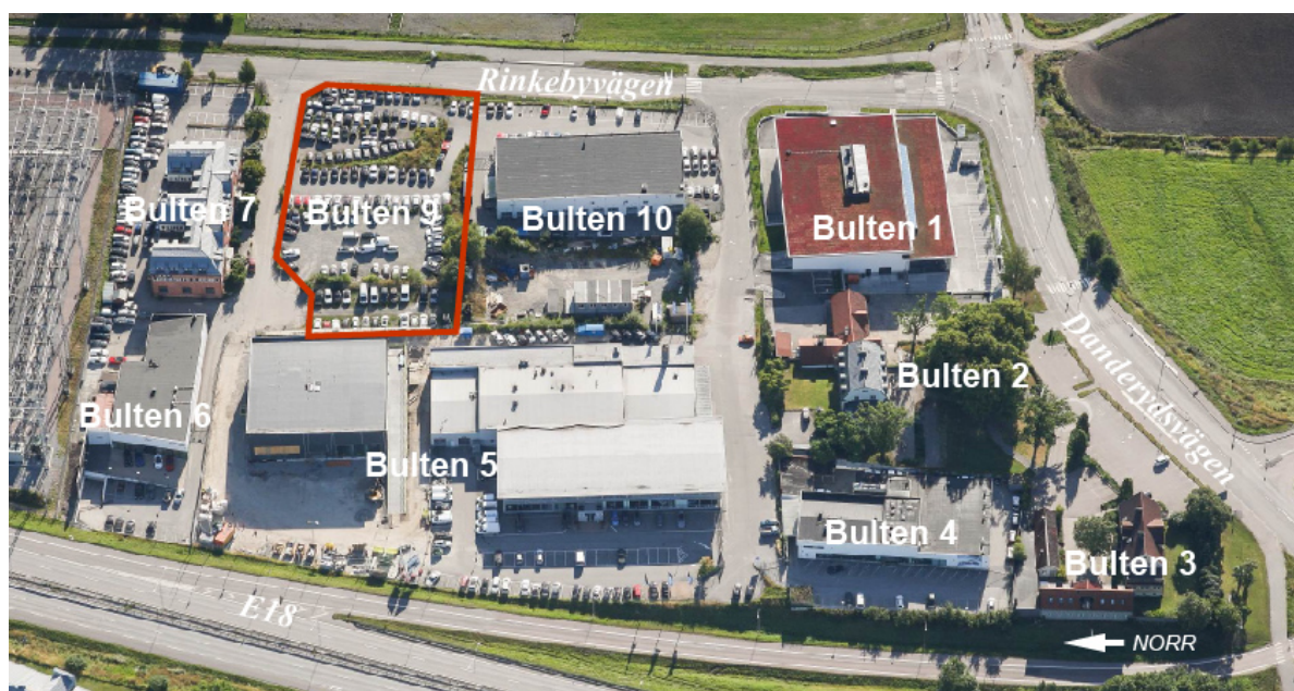
Befintlig situation inom kvarteret Bulten (vy mot öst).
