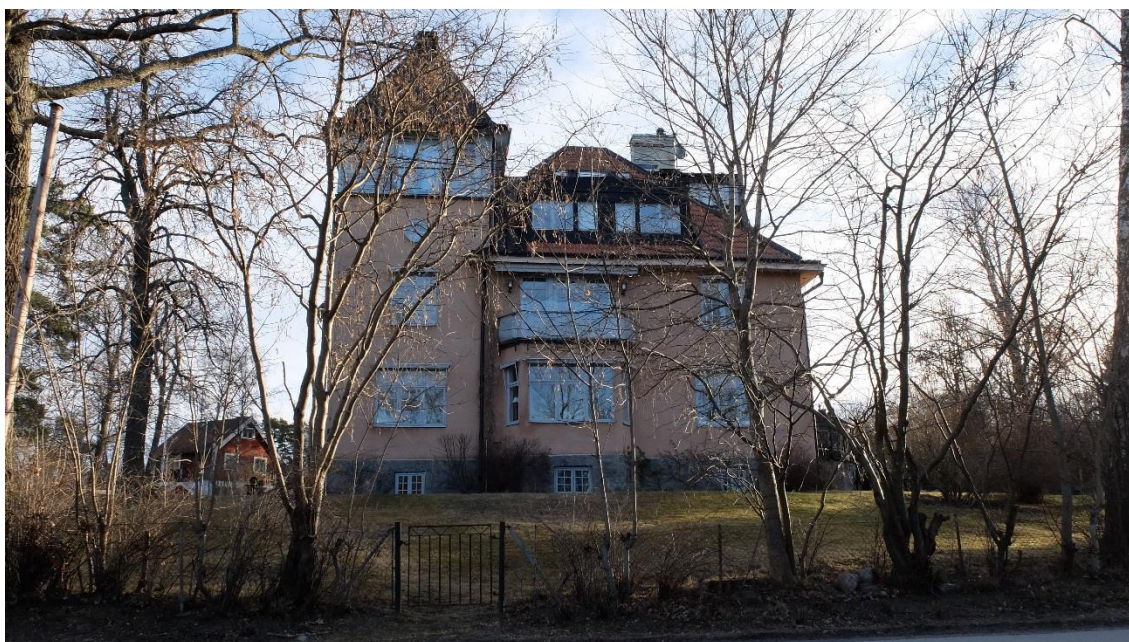
Villan sedd från samma håll idag. Ombyggnader har till viss del satt sin prägel på huset, men ursprungsvolymerorna kvarstår. Tornaltanen har blivit inbyggd, den mindre takkupan har blivit ersatt av en långsträckt plåtinklädd kupa som dominerar takfallet, det ovala fönstret är igensatt och balkongens genomskiktiga träbalustrad är utbytt.
