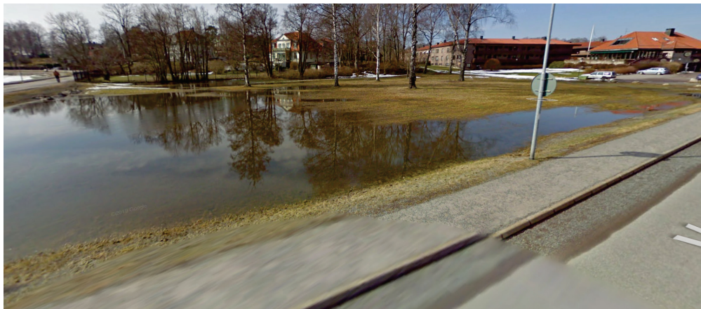
Foto 2 Befintlig situation vid extrema regn i kombination med extremt högvatten i Värtan Se februari 2020
