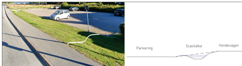
Bild 3 Svackdike längs befintlig parkering
