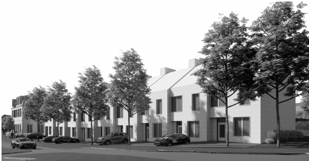
Radhusens fasader sett från Fafnerstigen.
