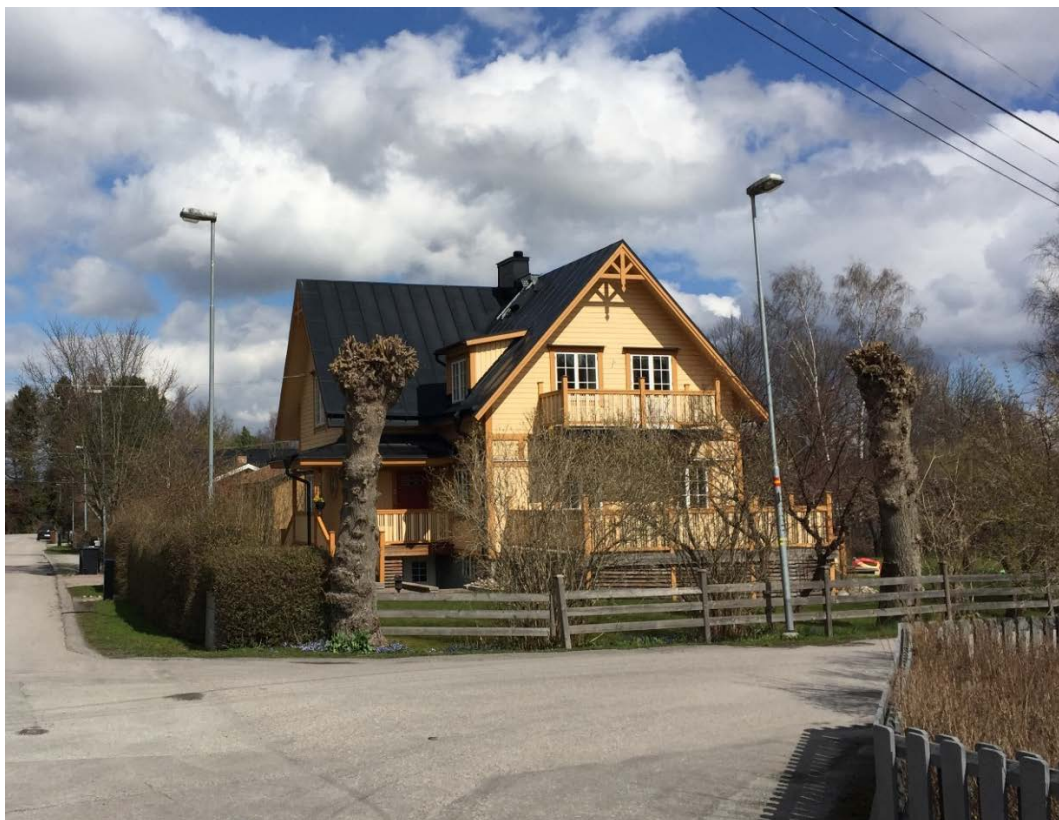
Befintligt hus inom Tranan 10. Foto taget från korsningen Idrottsvägen/Norrhagsvägen
