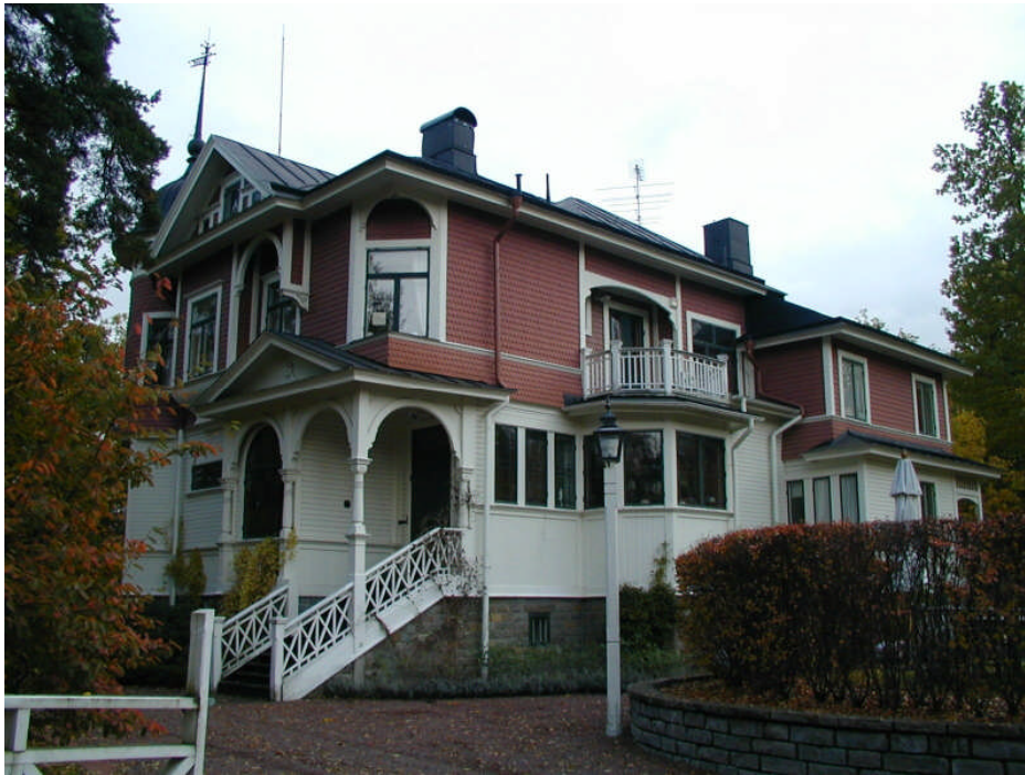
Lorride 7, Tulevägen 15, är byggnadsminne.
