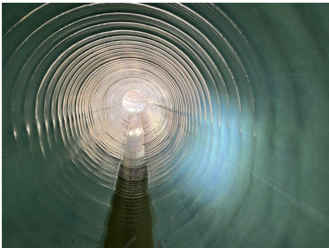
Figur 1, Renoverad dagvattenledning, Nora torg Fotograf: Simon Åkerlund
