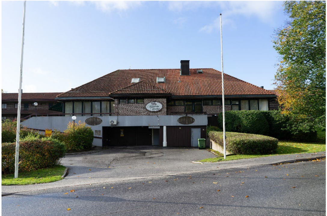
Figur 4. Befintlig vårdhusbyggnad från Vendevägen.
