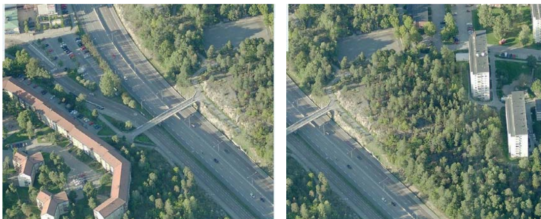
Figur 13. Bilder över bostadsbyggnaderna väster respektive öster om E18.
