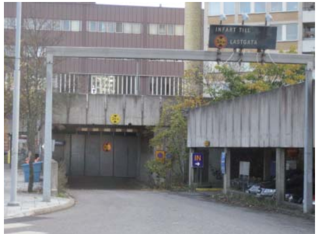
Befintligt lastintag från det norra torget
