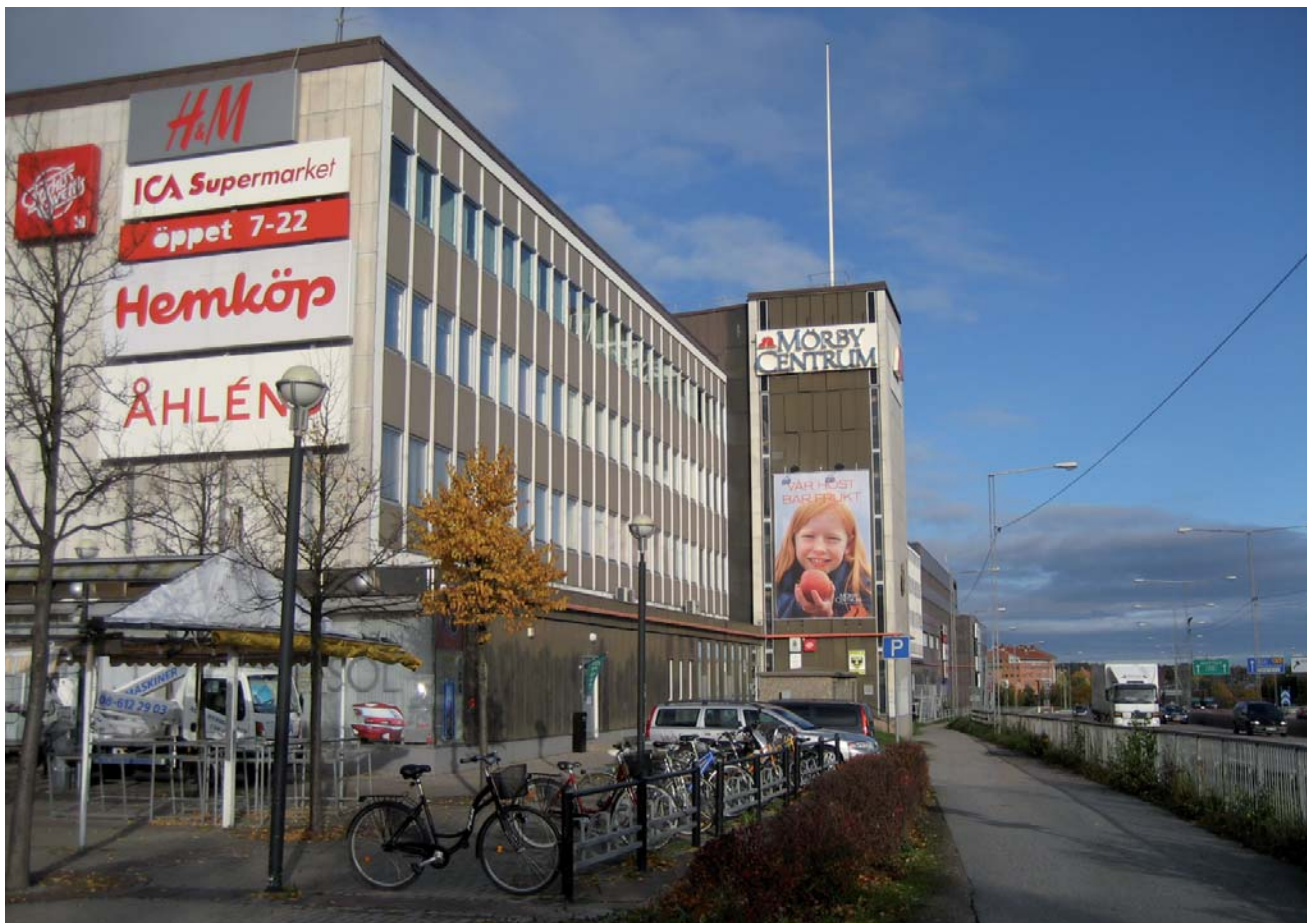
Mörby Centrums galleria mot E18
