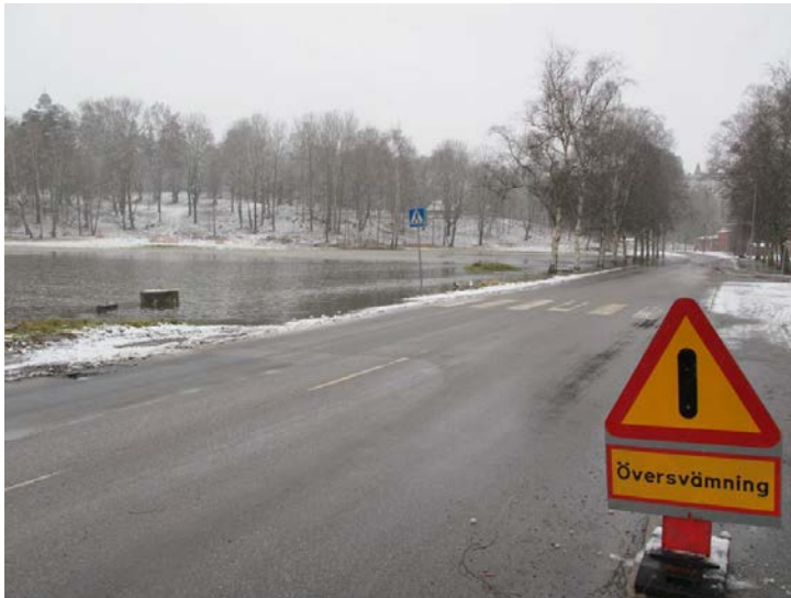
Figur 9, översvämning i Framnäsparken, Djursholm, januari 2012
