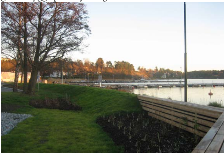
Figur 2, översvämningsskydd vid Nora strand
