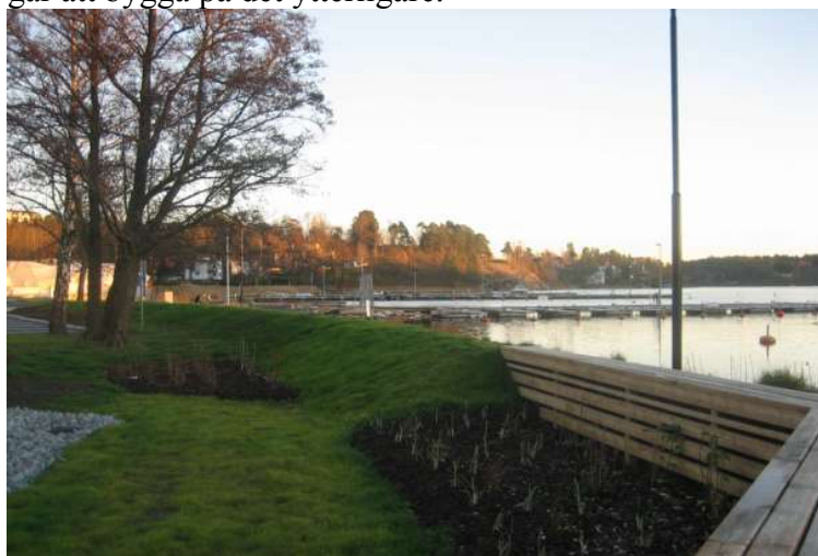
Figur 2, översvämningsskydd vid Nora strand
