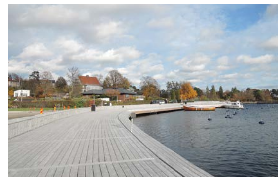
Den nya kajen vid Samsövikens som färdigställdes hösten 2019.
