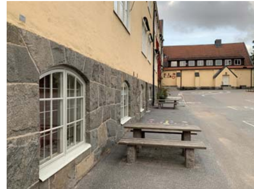
Suterrängsvåning med kvaderhuggen sockel av granit och bågformade fönster.
