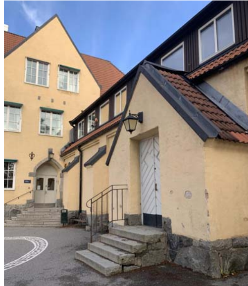
Anslutning av gymnastikssalsbyggnad mot skolbyggnaden. Händelserik hörna där entréer och portiker och utskjutande element och detaljer sammanhålls av enhetlighet i material och kulör.
