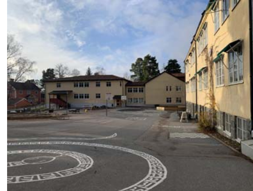
Huvudbyggnad till höger och 1960-talets matsalsbyggnad i fonden med tillbyggnad från 2000-tal. Skolgården framför husen är lätt lutande upp mot huvudentrén där bilden är tagen ifrån.
