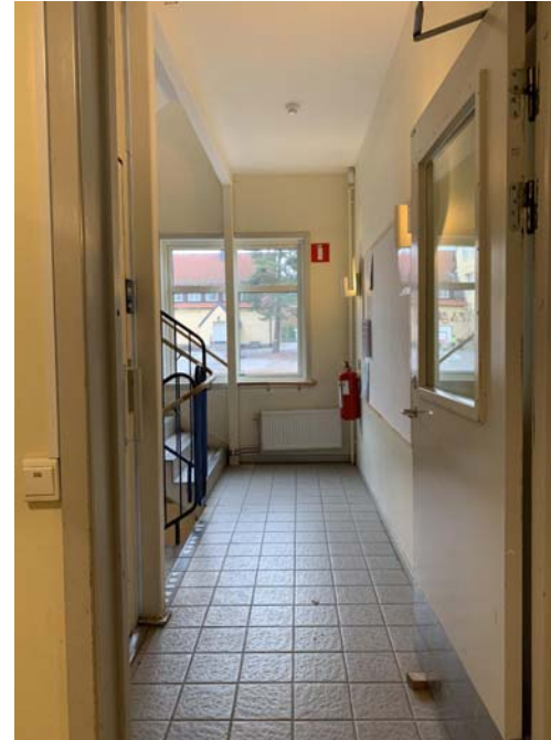
Vid trapphuset är en stålkonstruktion som ansluter mot fönstrets mittpost.
