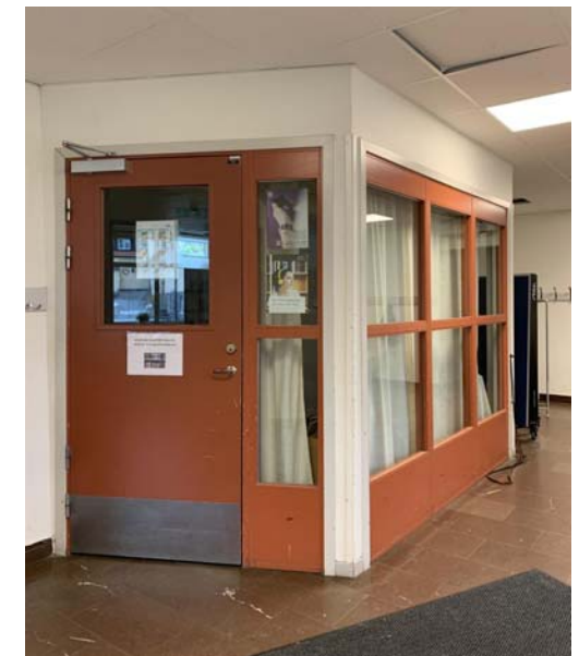
Dörr- och glasparti till biblioteket är troligen ett senare tillägg, liksom undertaksplattorna i tak.
