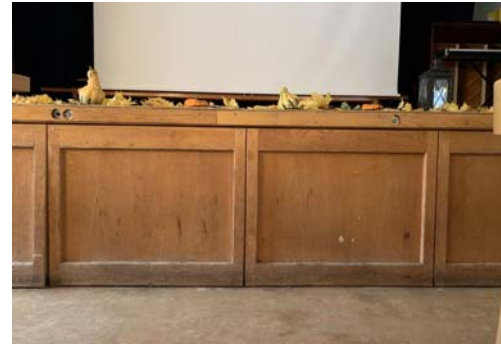
Fonten till upphöjda scenen är i trä med ramprofil.
