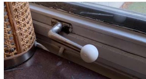
Fönsterbeslag är original utförande. Fönsterbänk i rödpolerad kalksten
