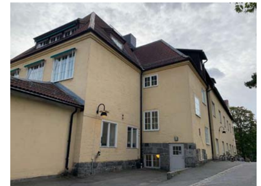
Huvudbyggnadens nord-östra fasad. Många livskillnader och volymanslutningar är ursprungliga. Bakom stupröret till höger skjuter tillbyggnaden från 2001 ut.
