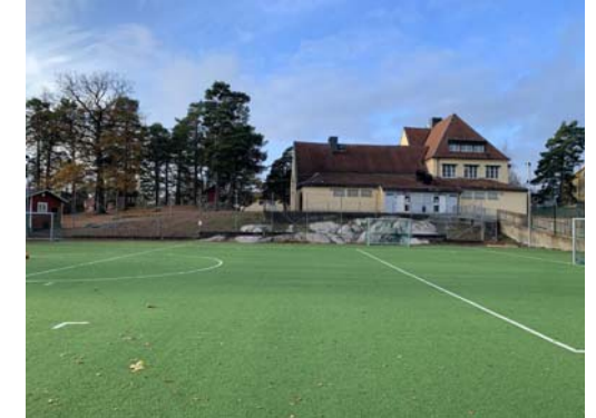
Vy från öster. Idrottshallen ansluter mot skolbyggnadens lärosalar i 2 våningar. Kuperad naturmiljö med tallar söder om byggnaden.
