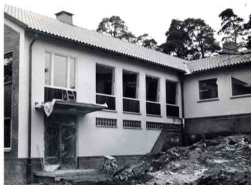
Matsalsbyggnaden under uppförande. Observera källarfönster av glasbetong som idag är utbytta. Källa: Hembygdsgörelsen Amorina
