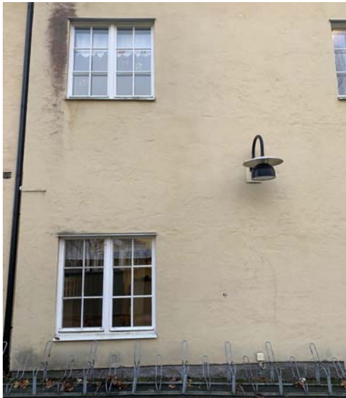
Tillbyggnaden har en utformning som harmonierar med den gamla byggnaden men håller inte lika hög kvalitet i material och utförande.
