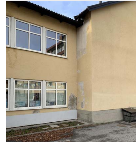
Den nyare byggnaden från 2000-talet ansluter till Matsalsbyggnaden med en liten livföskjutning. Kvaliten på fasaden är undermålig med puts direkt på isolering.
