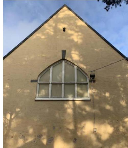
Fönster mot söder, bågformad med markerade slut- och anfangstenar.
