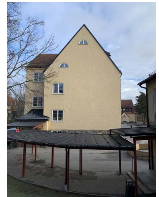
Gavelfasaden på huvudbyggnaden, anslutning mot matsalsbyggnaden via passage under skärmtak från 2000-talet.
