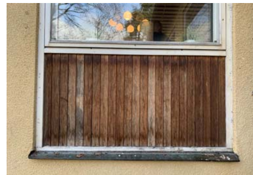
Ursprungliga fönster i trä med bröstningsparti av vertikala trästavar.
