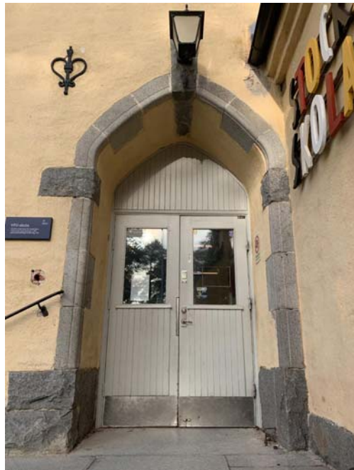
Indragen huvudentrén till huvudbyggnad. Ett bågvall med stenomfattning.
