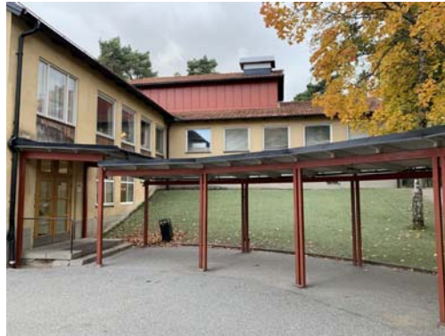
Matsalsbyggnadens huvudentrén med skärmtak som ansluter mot huvudbyggnaden. Marken lutar upp mot det övre våningsplanet, med yta beklädd med konstgräs.
