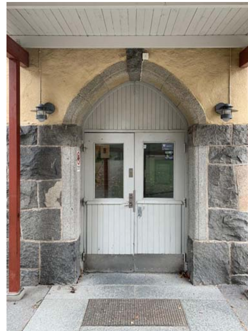
Entré mot väster. Stenomfattning med markerad slutsten och entréparti av vertikala träpanel. Dörrpartiet är från 1940-talet.
