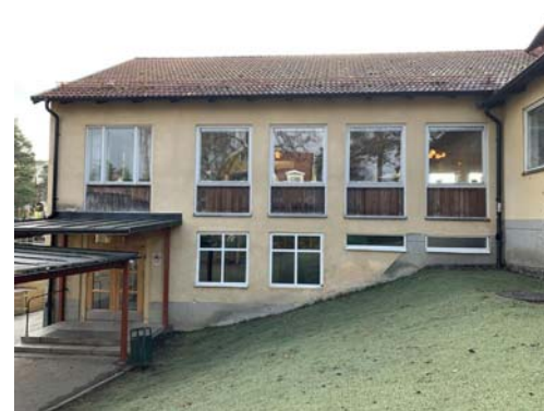
Ursprungliga fönster på ovanvåningen, men fönster har bytts ut på bottenvåningen. Här var ursprungligen smala ljusinsläpp av glasbetong.
