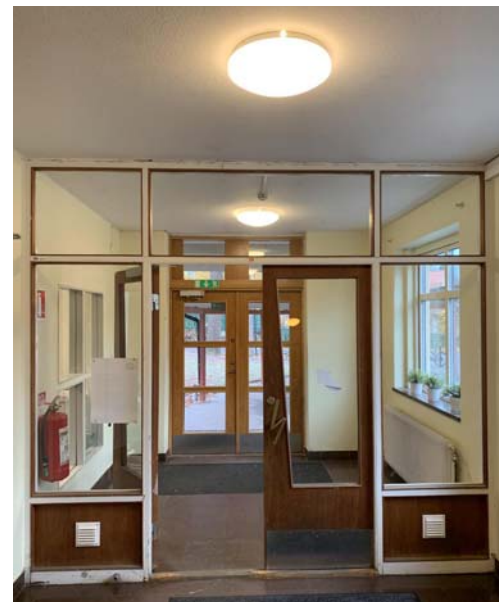
Glaspartier, entrépartier och fönster. Många olika bröstningshöjder, spröjs och material skapar ett osammanhängande uttryck på liten yta.
