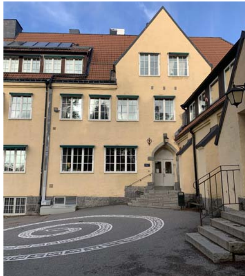
Idrottshall/ gymnastiksal till höger ansluter mot huvudbyggnad.
