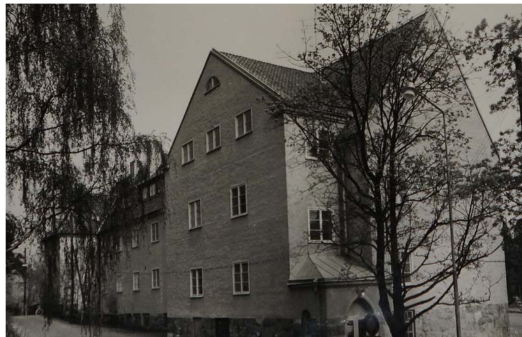
Huvudbyggnadens sydöstra och nordvästra fasader, 1978. Foto: Danderyds kommun.
