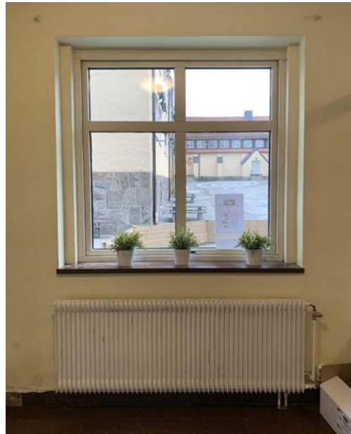
Fönster i entrén är från 2001. Fönsterbänk i rödpolerad kalksten är original. Den smala vattenburen radiatoren är även den från 1960-tal.
