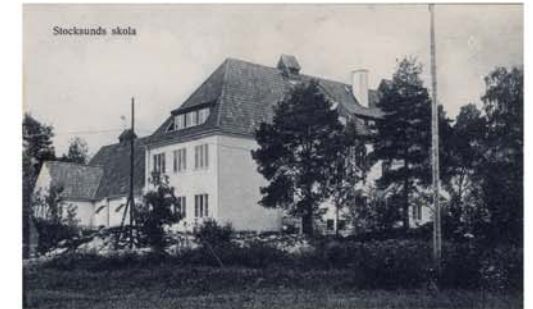
Huvudbyggnaden sett från nordost. Observera planformen före tillbyggnaden av gymnastikbyggnaden på 1960-talet. Källa: ibid.
