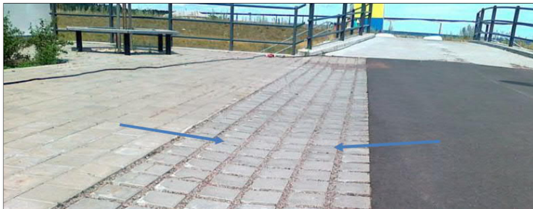
Figur 5. Genomsläpplig markbeläggning dit dagvatten kan rinna och infiltrera från omgivande hårdgjorda ytor (foto från Kalmar, Varvsholmen)
