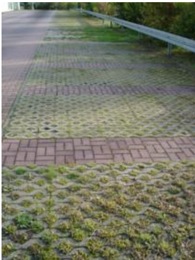
Figur 9. Hålstensbeläggning i parkeringsrutor med stensatta gångar emellan. Foto: WRS
