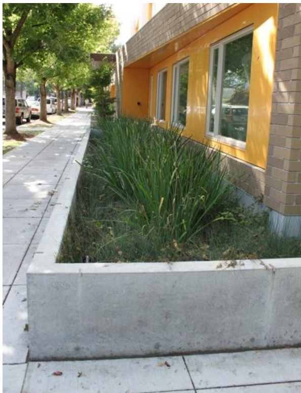
Figur 8. Exempel på växtbädd. Observera att växtbäddar kan anläggas utan något behov av mur runt omkring. Foto: WRS
