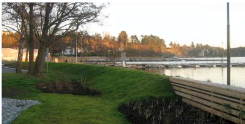
Översvämningsskydd vid Nora strand
