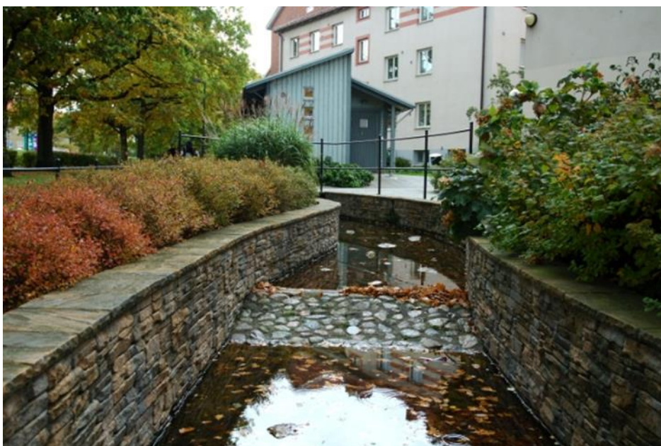
Figur 11. Dagvattenkanal med vertikala sidor.
