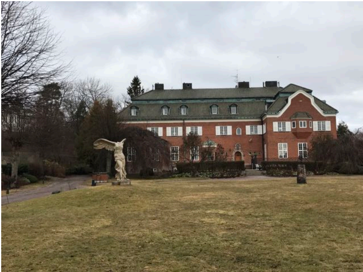
Foto på huvudbyggnadens framsida
