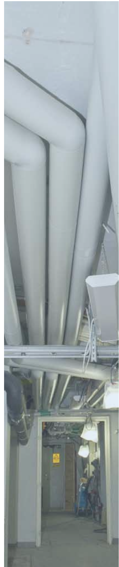
Exempel på kulvert med fri sektion 2,1 m x 1,2 m för passage.
