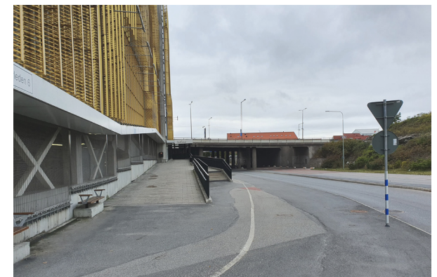
Mörbyleden västerut och mötet med parkeringshuset
