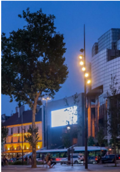
Figur 4 Högstolpar 10 m med spotlights.
