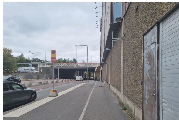
Mörbyleden, centrumbyggnadens slutna fasad.
