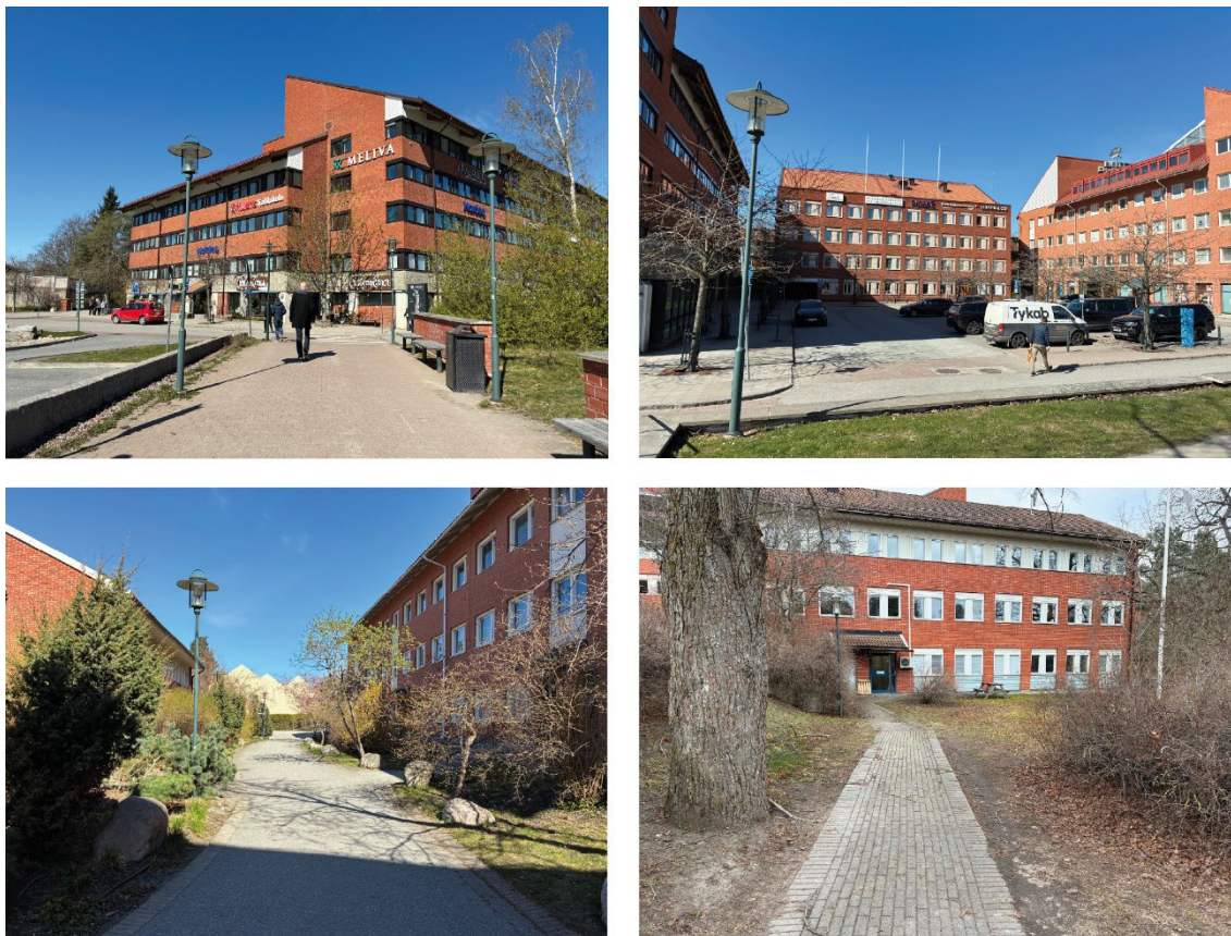
Figur 9. Befintlig bebyggelse inom planområdet. Överst till vänster: Fasad mot Mörbyleden. Överst till höger: Byggnader och markparkering mot Svärdvägen. Nederst till vänster: Klingstastråket. Nederst till höger: En av de byggnader som i planförslaget ges möjlighet till bostadsändamål.
