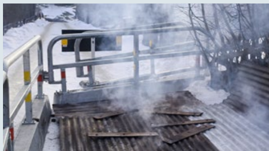
Marken tinas med glödande kol vid ett akut VA-arbete på Agantyrvägen i Djursholm.
