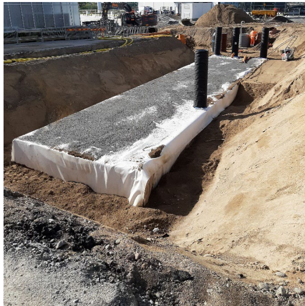
Figur 19. Underjordiska magasin som detta kassettmagasin i Järfälla (uppe) och Sollentuna (nere) kan användas i områden där ytor för anläggningar i marknivå saknas. (Foto: Bjerking).
