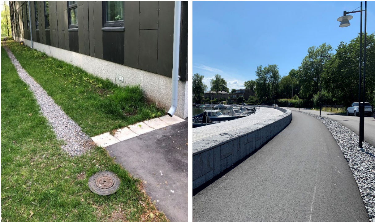
Figur 11. Makadamdiken kan anläggas både på kvartersmark samt allmän platsmark. T.V. visas fördröjning av takvatten från ett flerbildshus i Stockholm (Foto: Bjerking). T.H. är ett makadamdike mellan väg och gång- och cykelbana i Samsjövik i Danderyds östra delar (Foto: Danderyds kommun).
