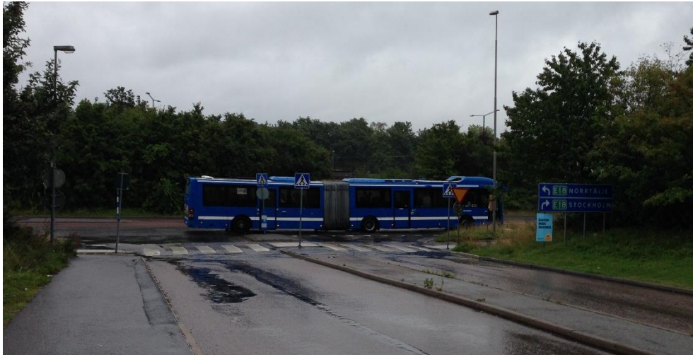
Figur 5-12 Buskage och vägs skyltning skymmer sikten i områdets utfart.
