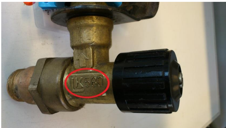
Figur 1. Ventil modell LK580, känd som "Champagnekorken". Denna ventil måste av säkerhetsskäl bytas ut av en våtrumsbehörig fackman innan vattenmätarbyte kan ske.
